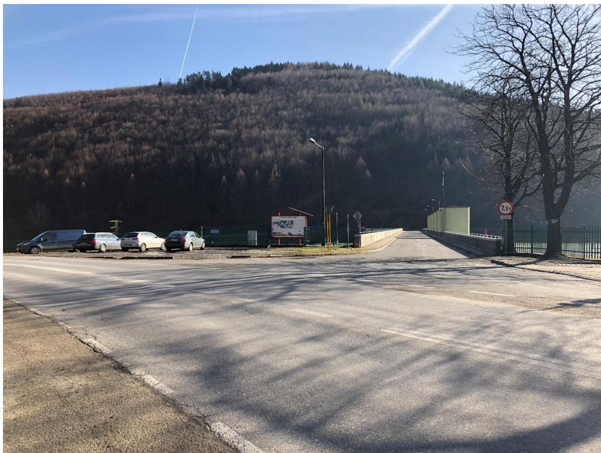
Tresna, Zapora Tresna
