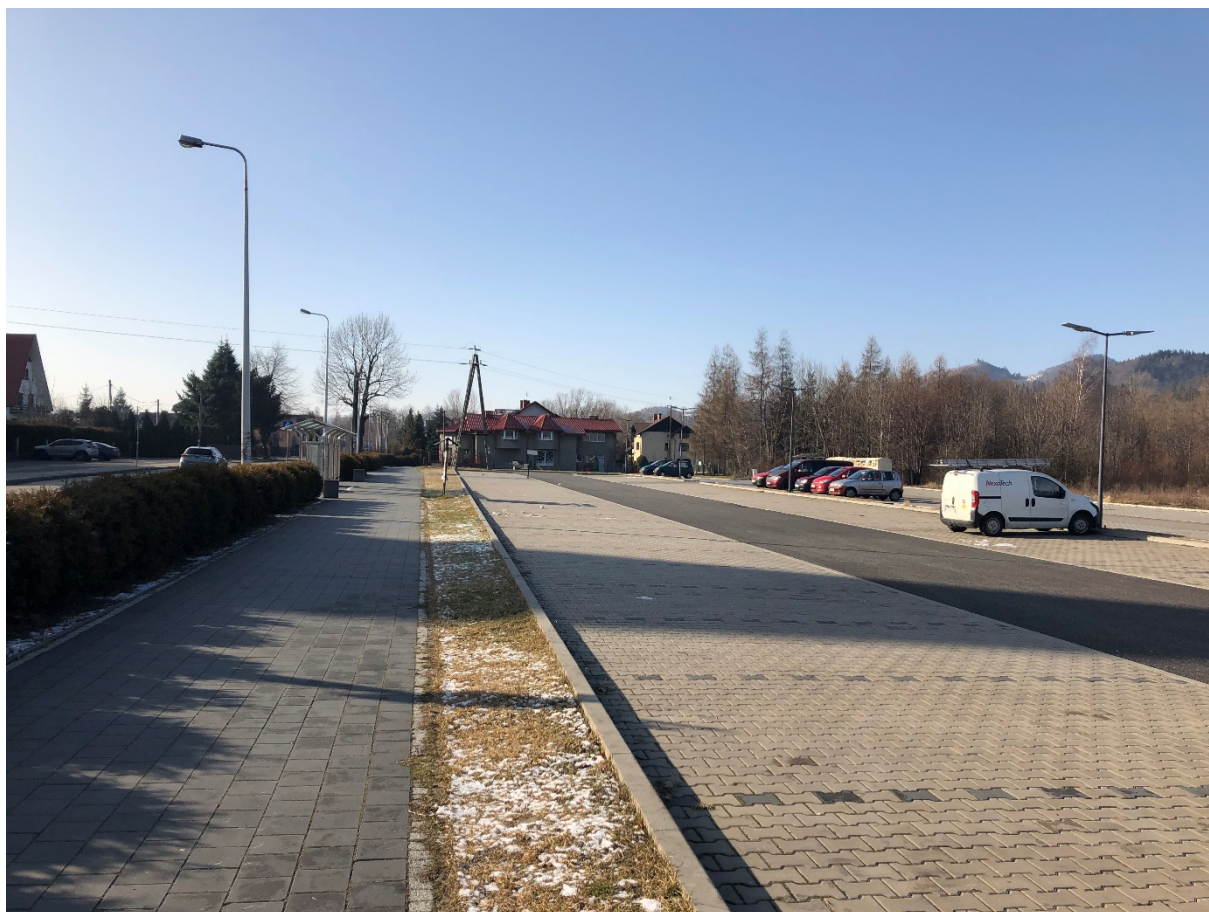
Węgierska Górka, parking przy kościele
