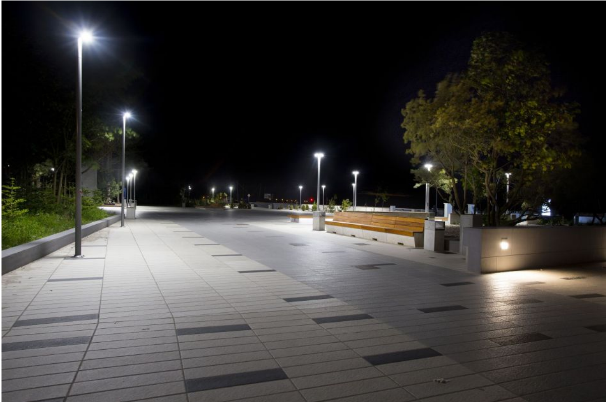
inteligentne oświetlenie uliczne
